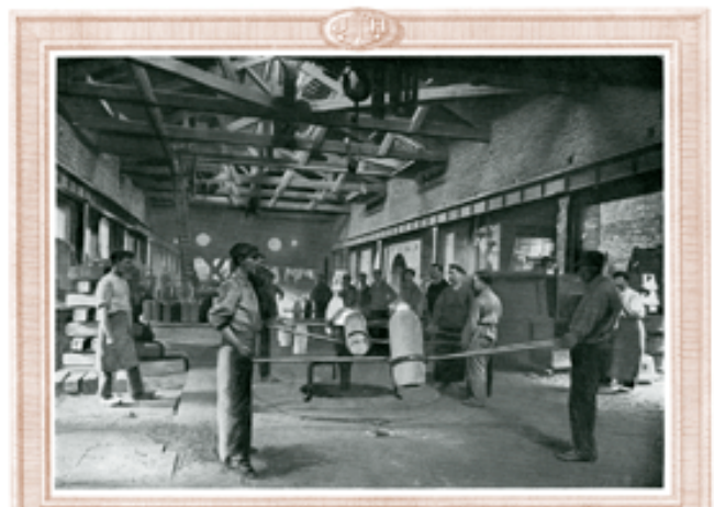
Coulée d'un gros lingot à l'aciérie Holtzer © Couriot Musée de la Mine
